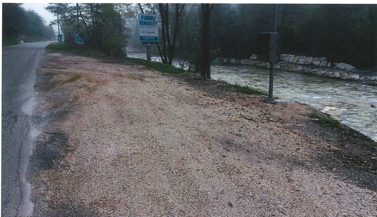
SEZIONE DI MISURA SUL FIUME CHIESE IN COMUNE DI VOBARNO — STAZIONE DI TELEMISURA E SOGLIA DI FONDO
